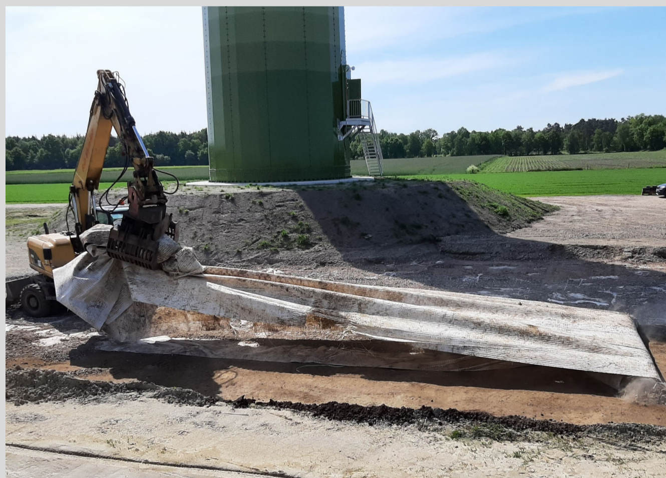
Aktuelles Vorgehen beim Rückbau von GEOK-Konstruktionen (Foto: FH Münster)
