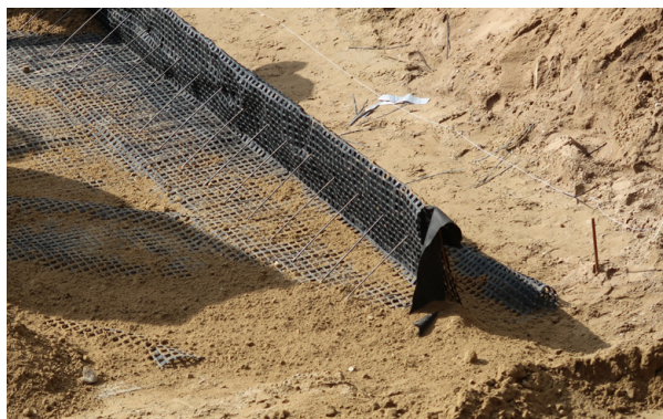
Geogitter-Bewehrung in einer Brückenkonstruktion.
