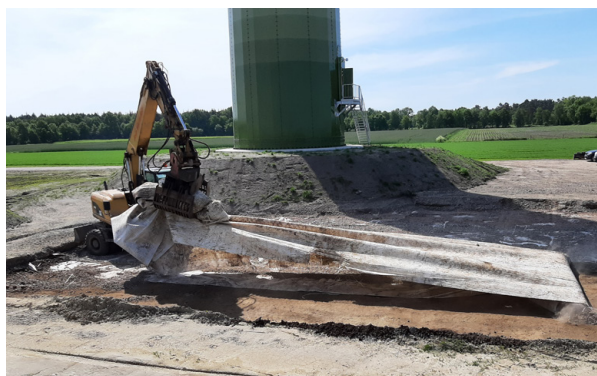
Rückbau eines Geokunststoffes.
